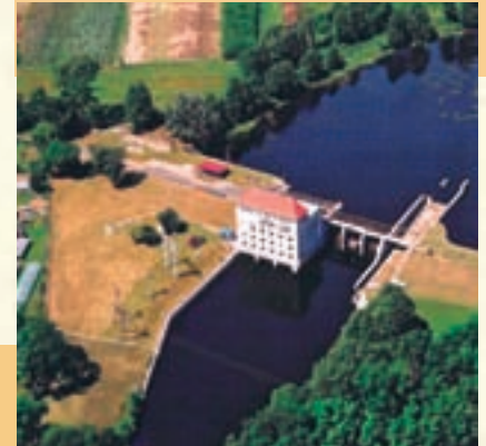
Elektrownia wodna w Dobrzyca.
