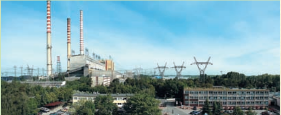
Elektrownia „Kozienice” S.A. zlokalizowana na lewym brzegu Wisły 75 km na południe od Warszawy to największy zawodowy wytwórca energii elektrycznej na węgiel kamienny w Polsce.
